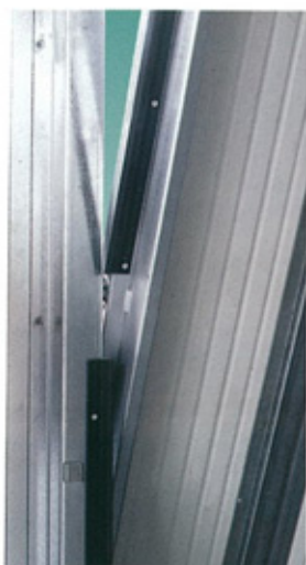
PARTICOLARE DELLE GUARNIZIONI DI TENUTA LATERALI (VISTA INTERNA)
